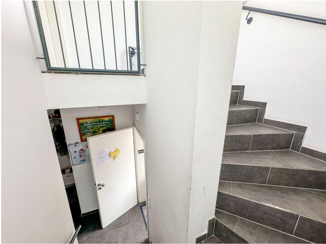
OG Treppenaufgang Studio
